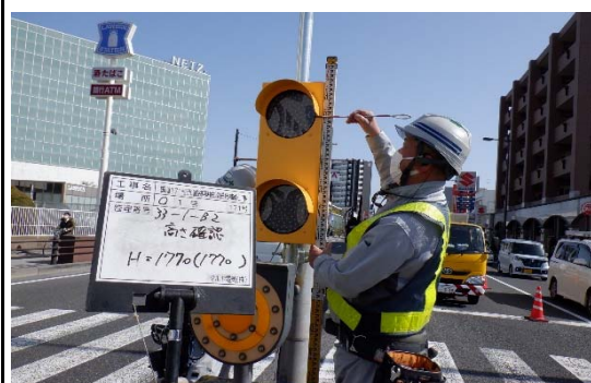
出来形管理 高さ確認
