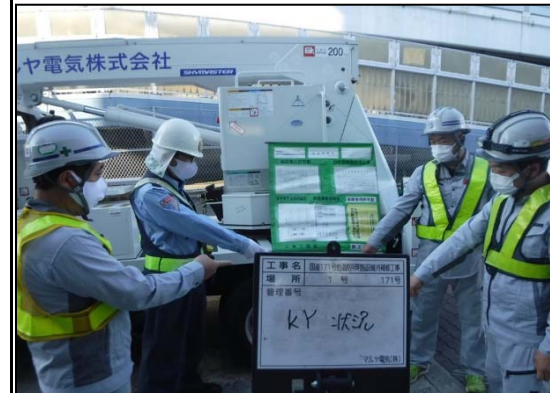
施工前KY状況
