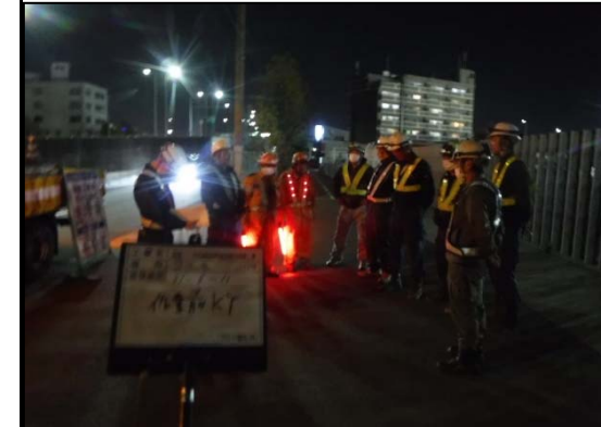
施工前KY状況
