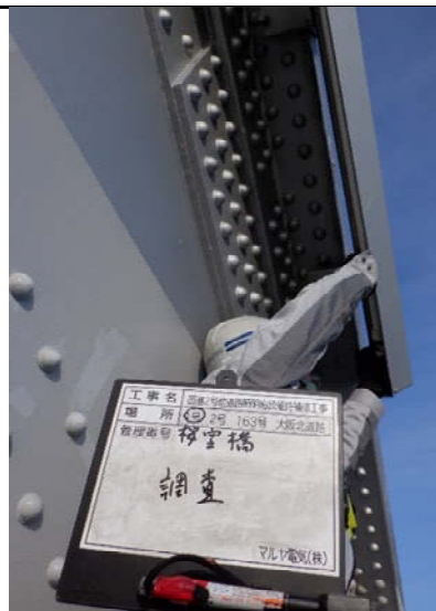
1号 桜ノ宮橋調査
