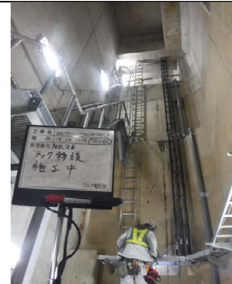
大阪ガス(ラック移設)
