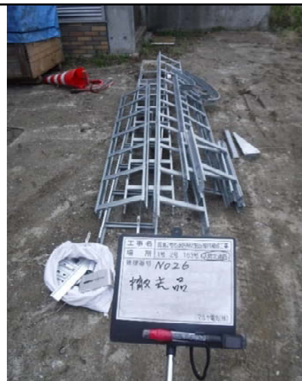
現場発生品運搬
