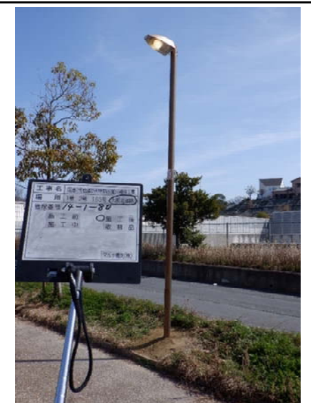
大阪ガス(照明柱復旧)
