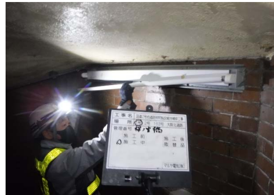
緊急 1号(桜ノ宮橋)
