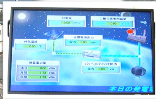
大阪南港市場太陽光発電設備設置工事
