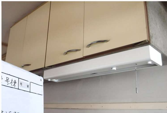
大阪市営住宅 メンテナンス工事
