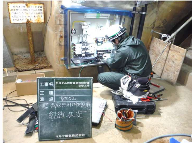
布目ダム 他監査廊照明設備改修工事
