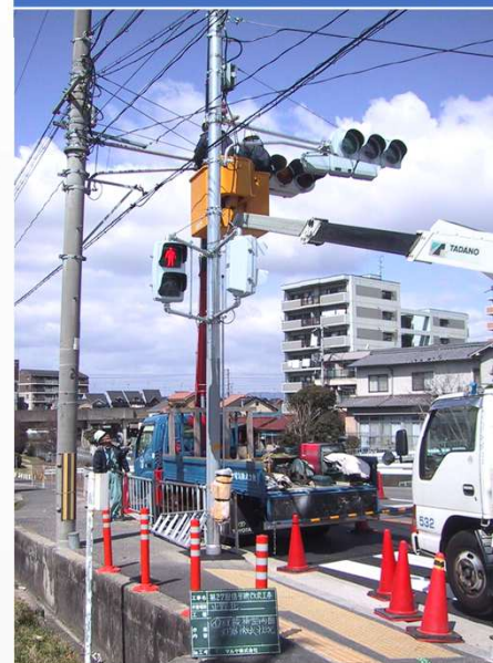
大阪府警本部 信号機改良工事
