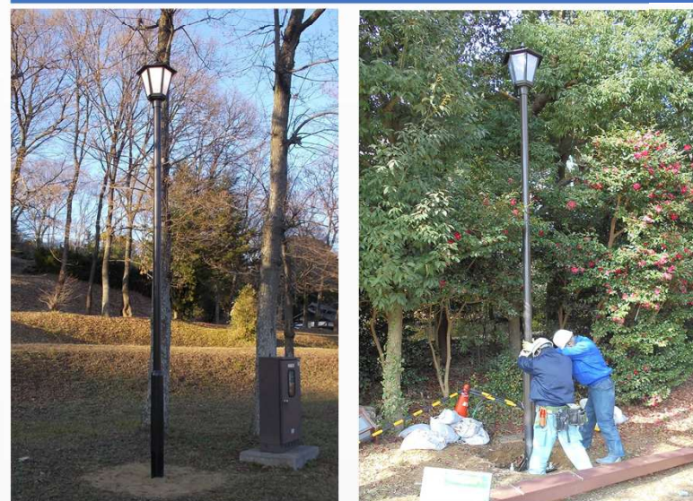
国営飛鳥歴史公園 照明灯設置工事
