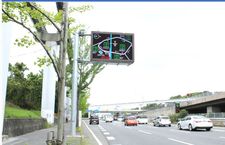
万博記念公園 駐車場用道路情報設備設置工事
