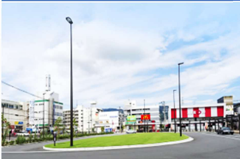
東花園駅前広場 線道路照明灯設置工事
